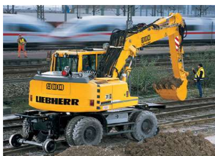
PELLE SUR RAIL (+ FORMATION CFF)
