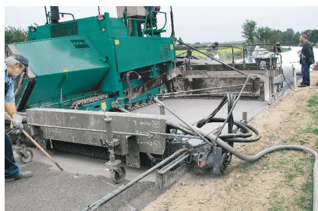
FINISSEUSE A BETON - RADIER - ROUTE
