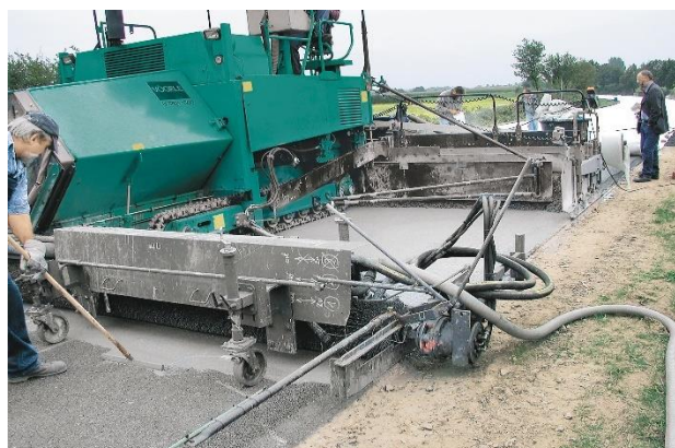
FINISSEUSE A BETON - RADIER - ROUTE
